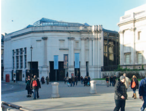
Kuva 58. Venturi, Scott Brown and Associates Inc. National Gallery, Sainsbury Wing, Lontoo (kilp. 1985–86, valm. 1991). Rakennusta koskevasta debatista lisää seuraavalla sivulla.
