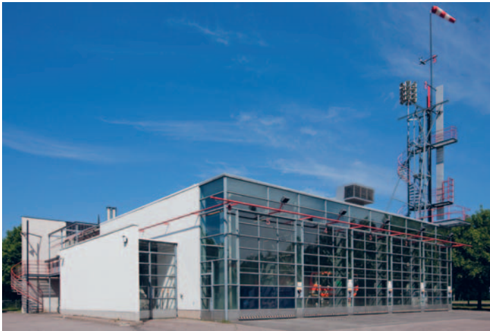
Kuva 3. Arkkitehdit Ky / Gullichsen-Kairamo-Vormala / Erkki Kairamo. Niittykummun paloasema, Espoo (1981). Modernistinen peruslaatikko on koristeltu näennäisen funktionaalisilla rakennusosilla.
