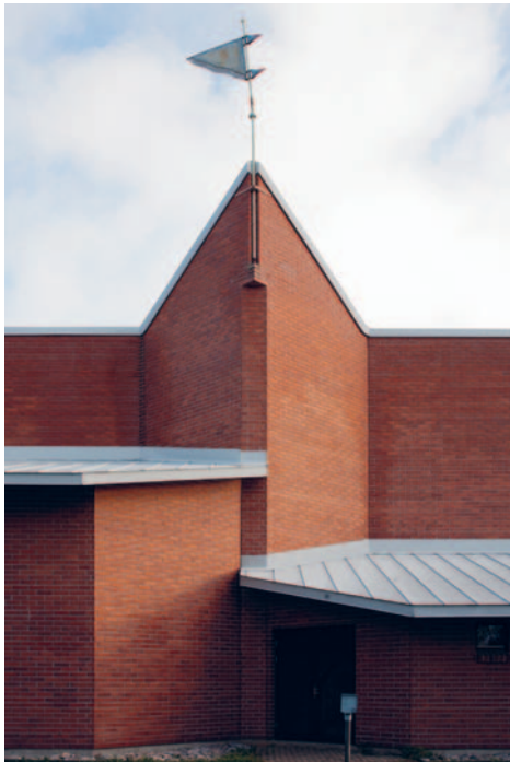
Kuva 51. Pekka Salminen. Liikuntakeskus, Virrat (1987). Muototiilimuurauksia, lähiympäristöä elävöittäviä rakennelmia, polveilevaa tilasomittelua, viistoja kattopintoja ja suomalaisen postmodernismin tunnusmerkki: tuuliviiri.
