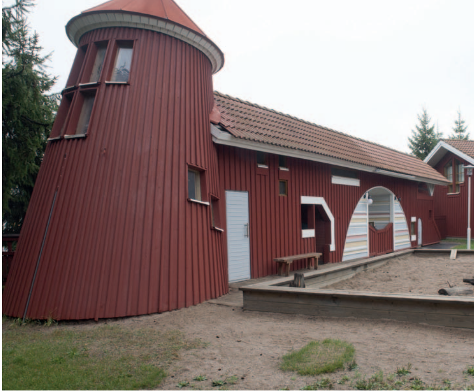
Kuva 41. Arkkitehtitoimisto NVV (Reijo Niskasaari, Kari Niskasaari ja Jorma Öhman). Toholammin kunnantalo (1987).
