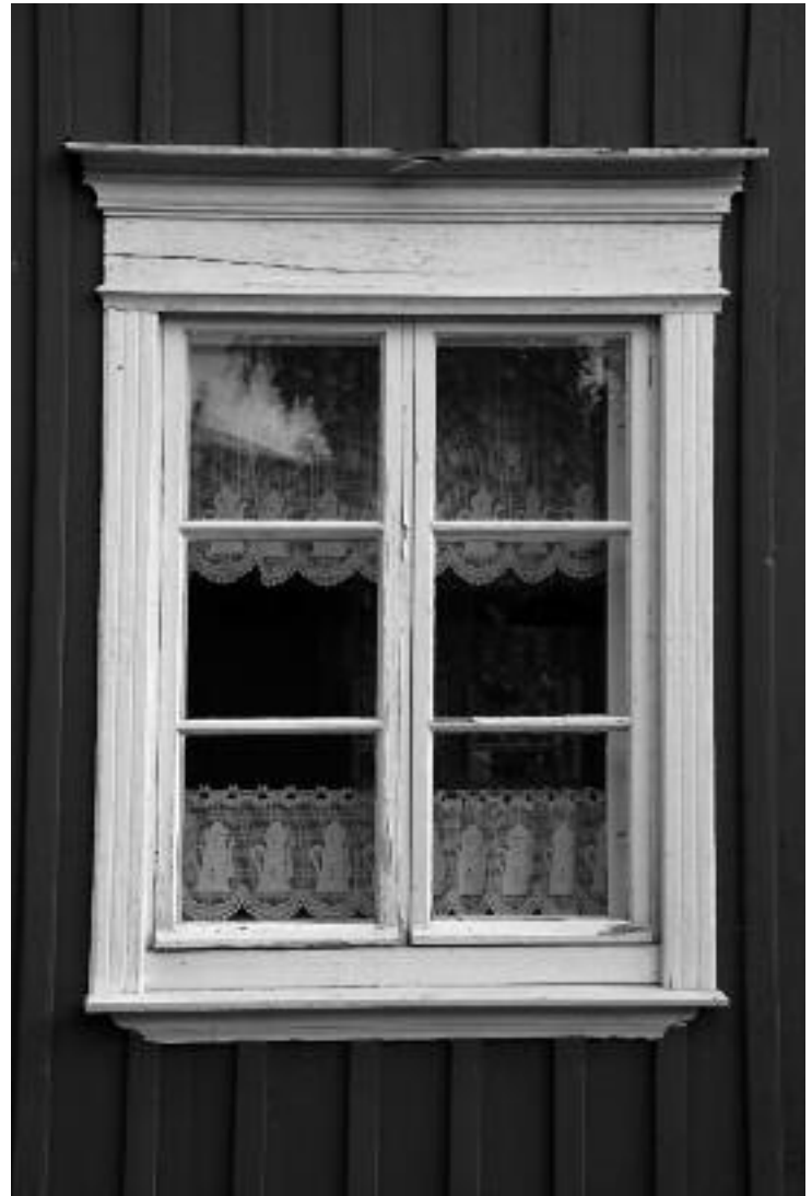
Kuva 221: Vanha Rauma, ikkuna ja pitsiverhot. KH 2011.
