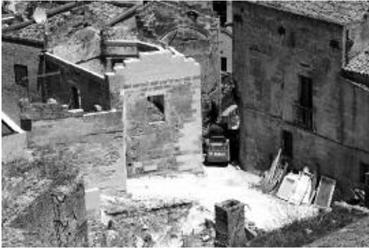
Kuva 205: Sassi di Matera, kuva korjaustyömaalta. KH 2012.
