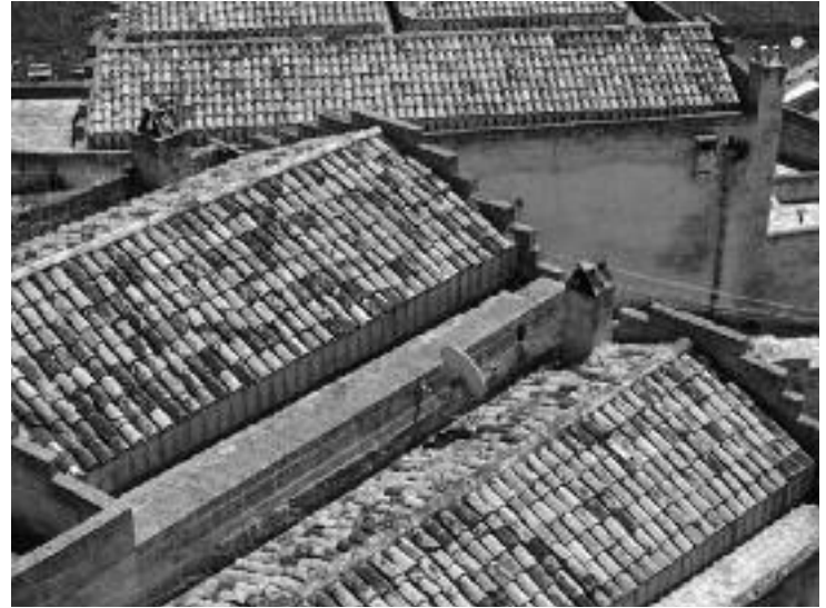
Kuva 197: Perinteisellä savisella kattotiilellä katettuja kattoja ylärinteestä nähtynä. KH 2010.
