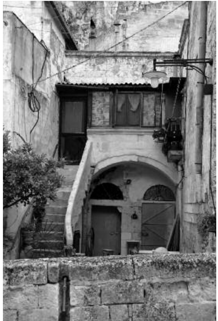
Kuva 199: Uudemmaa kansanrakentamista: luvatta katettu ja lasitettu porrastasanne. KH 2012.
