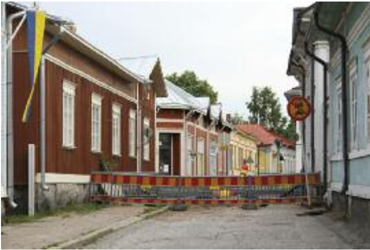
Kuva 172: Katutöitä Vanhassa Raumassa. KH 2011.
