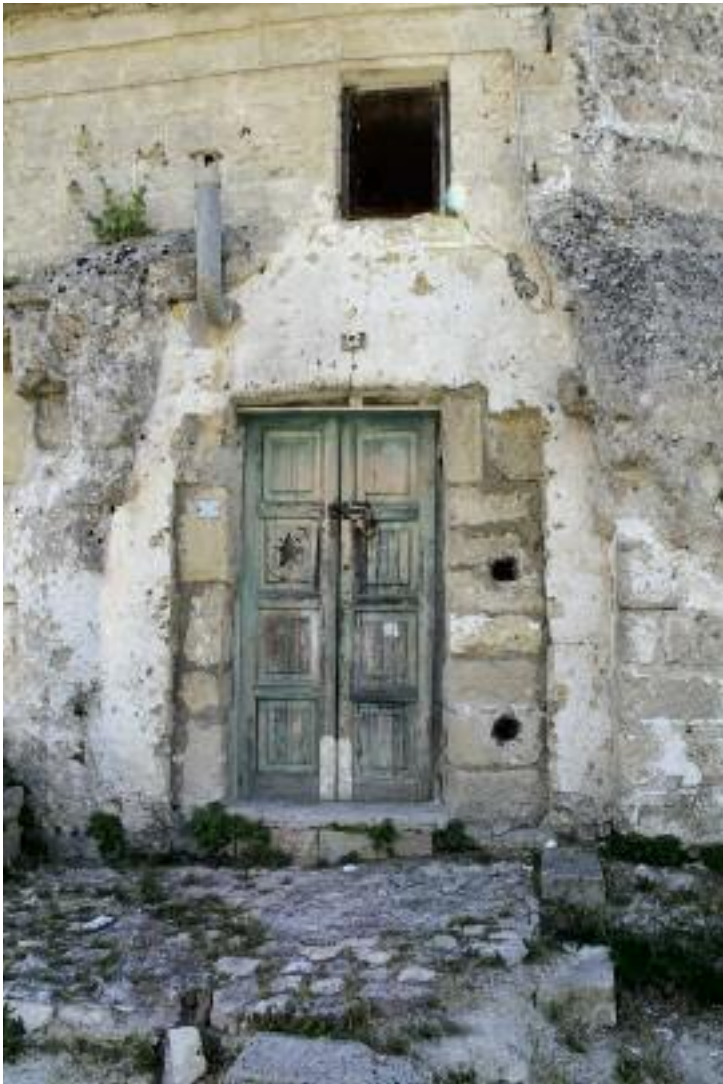
Kuva 139: Lukittu ja rapistunut ovi Materassa. KH 2012.
