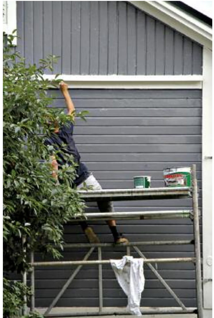
Kuva 159: Julkisivuverhouksen huolto Vanhassa Raumassa. KH 2011.
