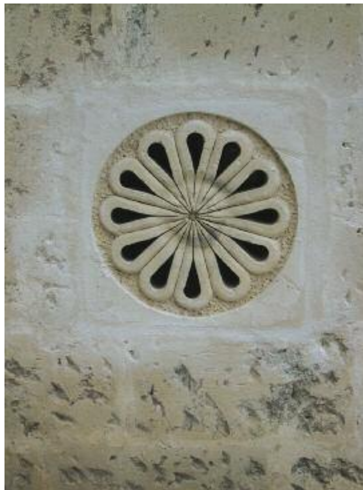
Kuva 146: Sassi di Matera, hienosisistä kalkkibiekkakivistä ( pietra leccese ) veistetty ilmanvaihtoräppänä. KH 2010.
