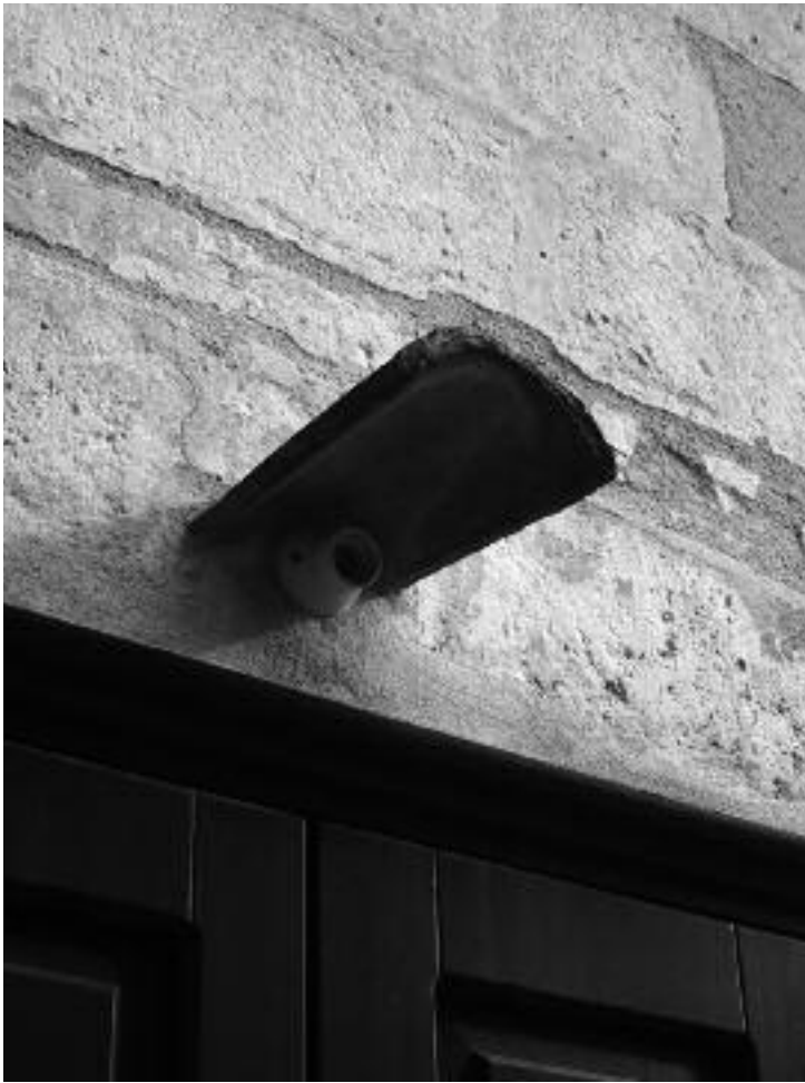
Kuva 200: Kattotiilestä tehty ulkovalaisimen kate. KH 2010.
