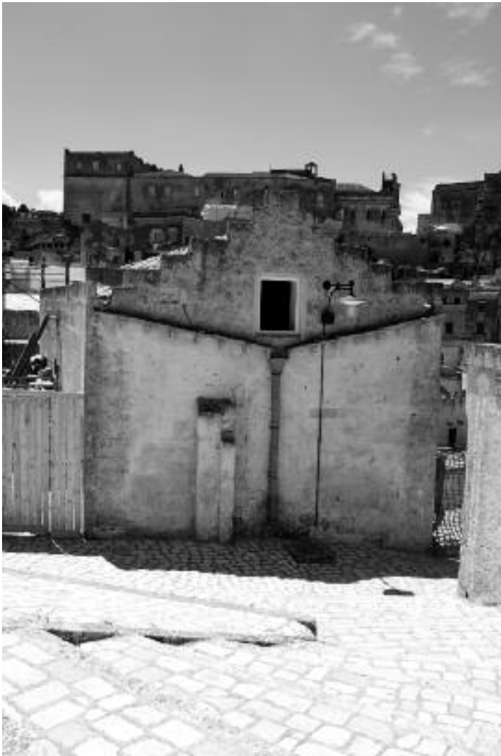
Kuva 198: Terrakottaiset vesikourut ja syöksytorvi. KH 2012.
