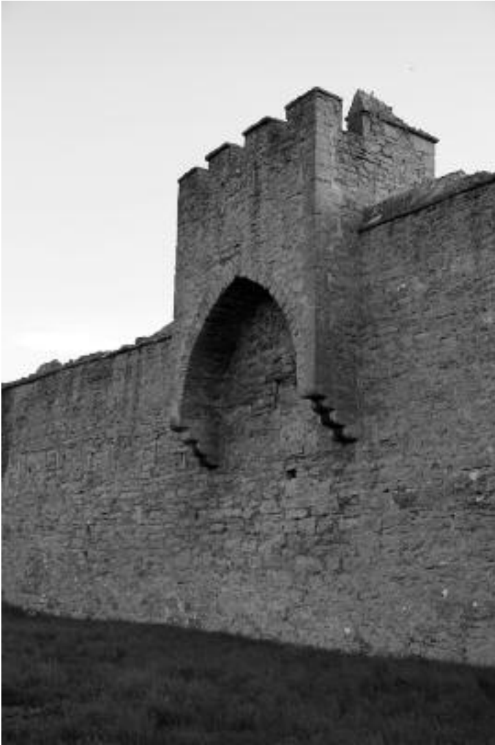
Kuva 41: Visbyn kaupunginmuuri; satulatorni. KH 2011.
