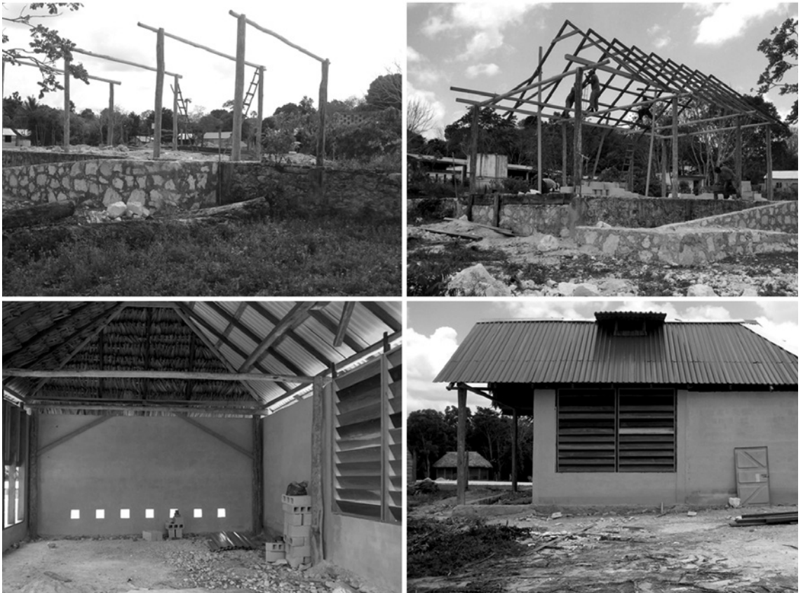
Figura 28. Fotos por Miriam Cabuich mostrando las diferentes etapas de construcción. Publicadas en Garduño 2015 (121)
