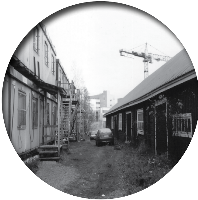
Tiedepuiston rakentamista Viikin latokartanon maismassa.
