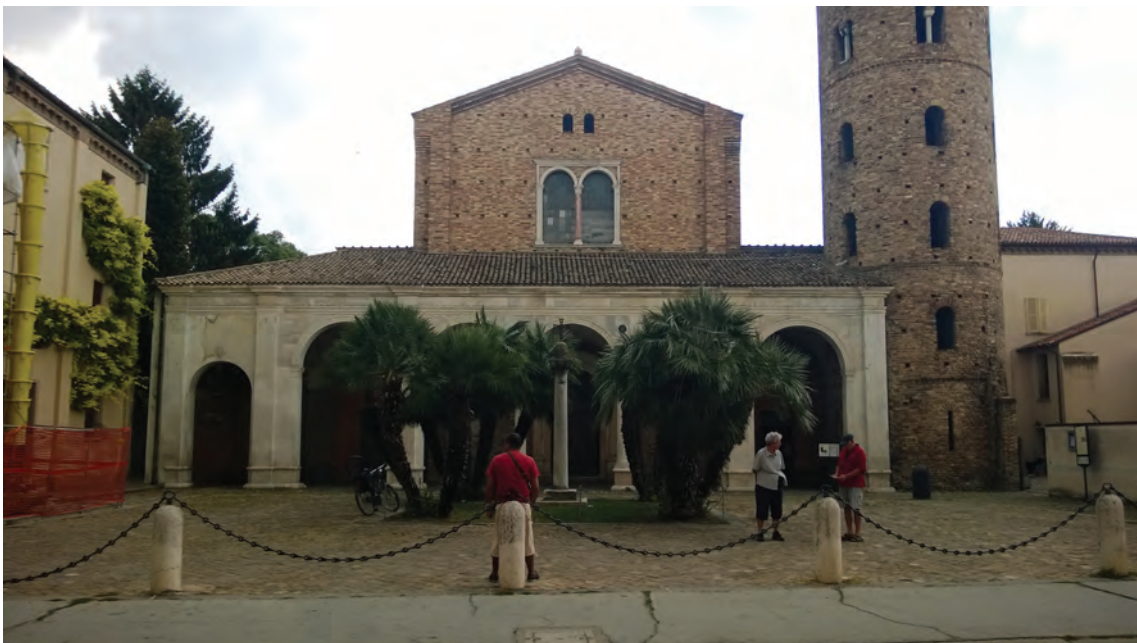
Fig. 2.2.18. Basilica di Sant'Apollinare Nuovo, façade.
